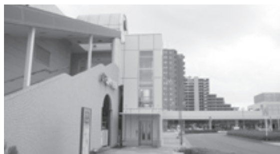
JR酒々井駅自由通路西口エレベーター
