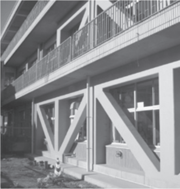
ピタコラム工法で補強された酒々井小学校北校舎
