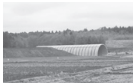
工事が進むアクセス道路（高崎川横断部）
