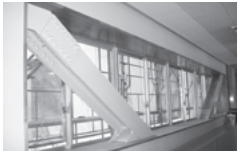
鉄骨ブレースで補強された大室台小学校校舎
