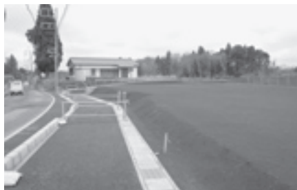
造成工事が進む南部地区新産業団地（飯積コミュニティセンター付近）
