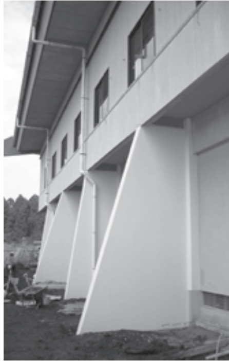
酒々井中学校体育館外壁の耐震補強
