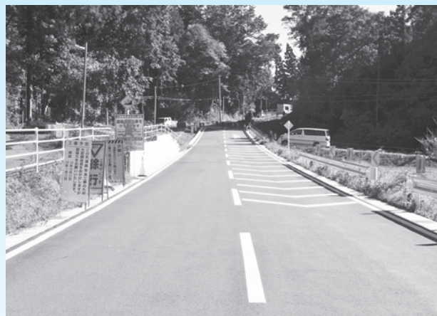
早期完成が待たれる本佐倉地先の町道 02-011 号線
