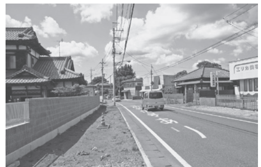
無電柱化の工事が進められている町道（横町線）
