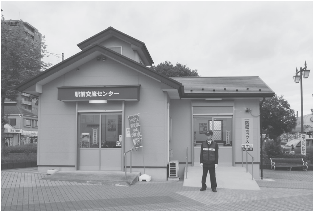
駅前交流センターに増築された「防犯ボックス」 地域を守る新たな担い手が誕生しました
