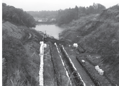
馬橋川上流部補修工事
