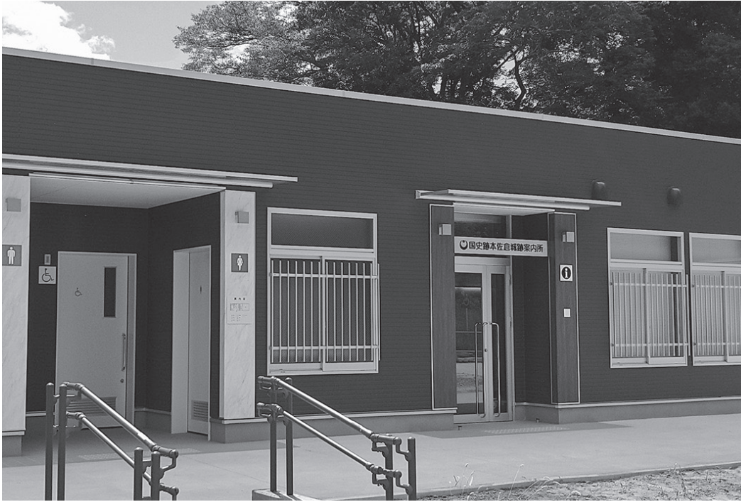
ボランティアガイドが待機する案内所やトイレなどを整備した 国史跡本佐倉城跡案内所
