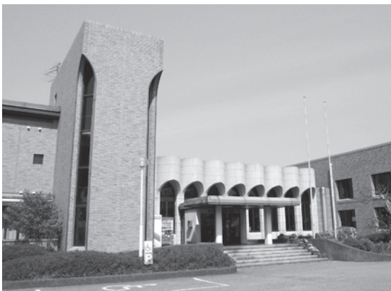
施設整備の工事を予定している中央公民館
