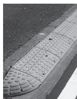
乗り上げブロックは、転倒事故等、思わぬ事故の発生原因となります
