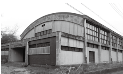
令和6年度中に解体工事を行う町体育館
