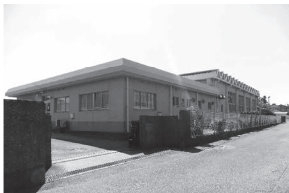
センター正面入口
