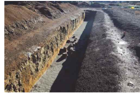
平成 29 年度範囲確認調査 9-3 トレンチ遺構 保護(砂入れ)状況
