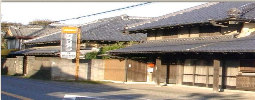
上 修景前 看板、ブロック塀が風景を阻害していました。
