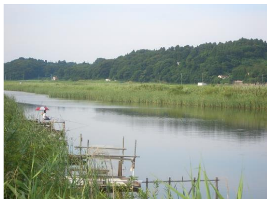
印旛沼中央排水路
