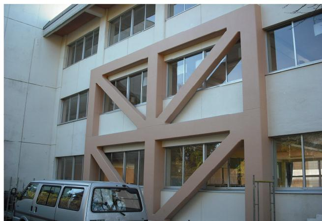
ピタコラム工法による耐震補強工事が完了しました。補強部分は、既存の外壁やタイルの色との調和を図りました。
