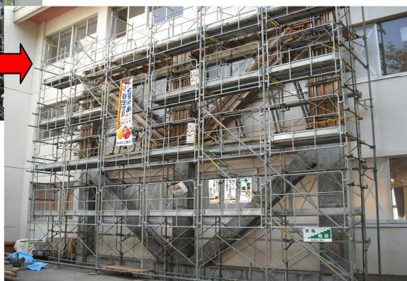
鋼板のフレームを楕円形の鉄筋で巻き、厚さ約30cmのコンクリートで固めます。左の写真と比べてみてください。
