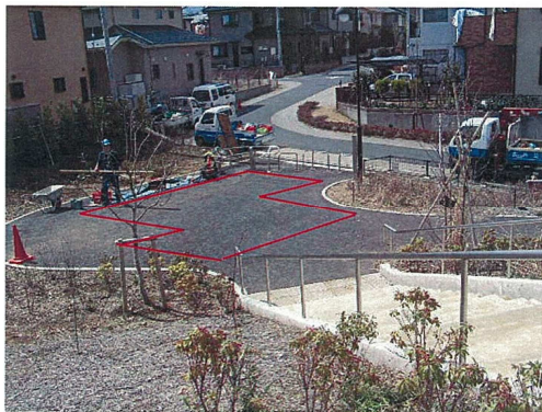
8号街区公園の設置例
