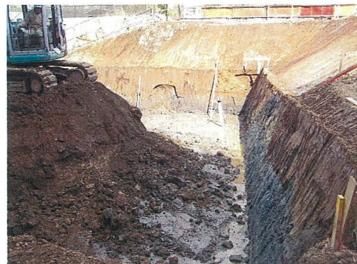
34号緑地の施工中写真
