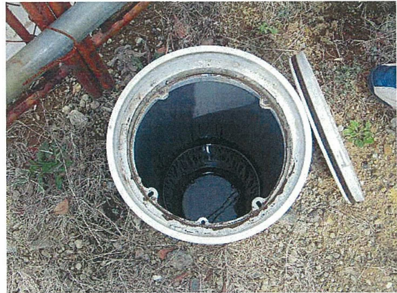
9号街区公園の設置例
