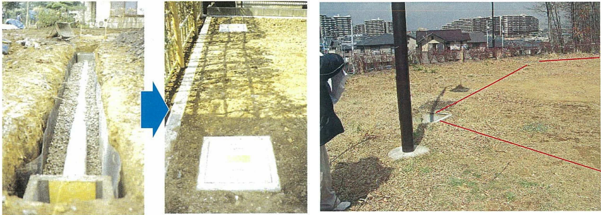
浸透トレンチの施工状況
