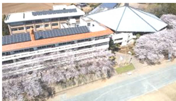
上空から撮影した校舎・屋内運動場
