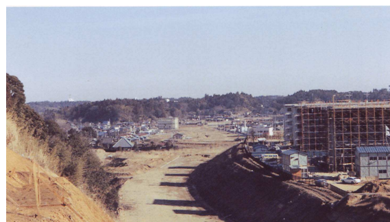
国道51号線バイパス工事(昭和55年)
