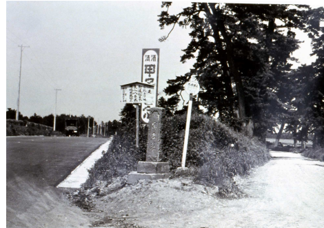
伊籾松並木 (写真右側) 旧国道51号線
