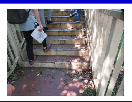
歩道橋階段の滑り止めが破損していて危険な状態 である。
