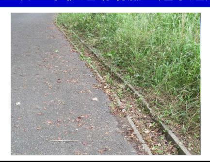
側溝に土砂が堆積している。そのため雨天時に排 水がうまくいかず冠水がおこる。
