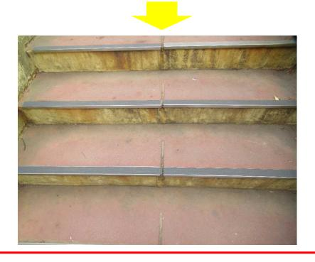
歩道橋の破損している箇所を中心に点検し、新しい 滑り止めを設置した。
