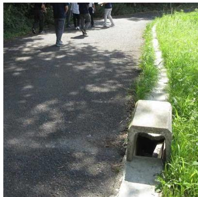
昨年度中に側溝の蓋について修理が完了している。今年度に入り再び破損していたが、ブロックを設置して対処済みである。除草作業も実施した。
