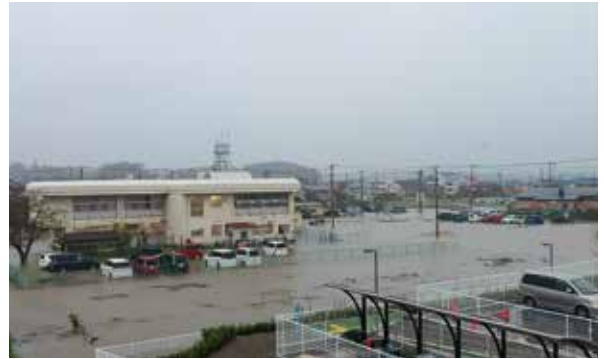
岩橋保育園付近の冠水被害（令和元年）
