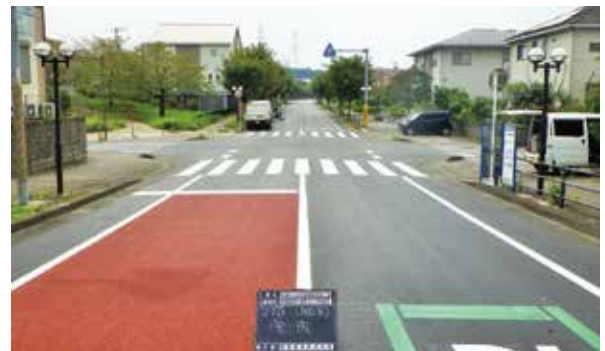
修繕後の道路
