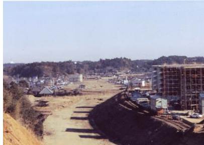
工事中の国道51号バイパス（昭和55年）
