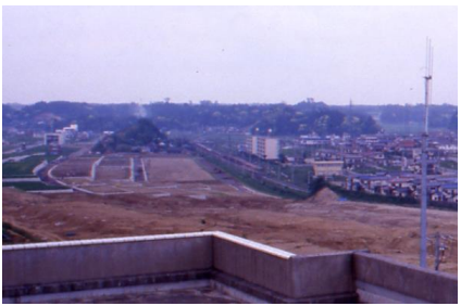
役場屋上から見た、造成中の中央台団地
