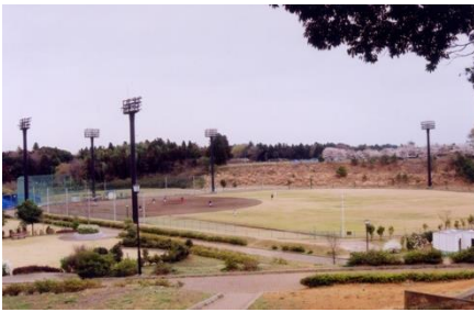
昭和63年総合公園野球場完成
