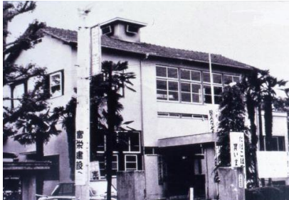
現JA成田市酒々井支所 にあった旧役場庁舎
