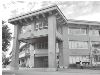
長寿命化改修工事を予定している酒々井小学校
