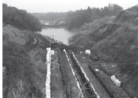
馬橋川上流部補修工事
