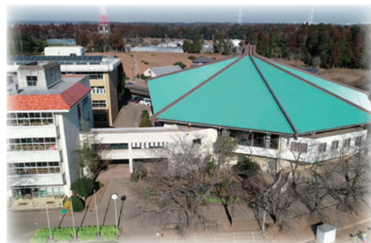
酒々井中学校屋内運動場大規模改修工事が完成しました
