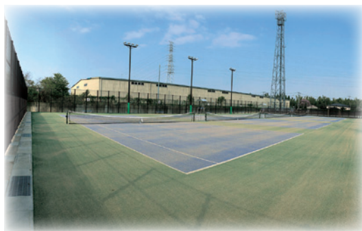
移設（新設）された酒々井中学校テニスコート
