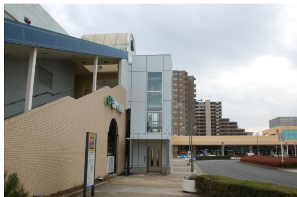
JR酒々井駅のエレベーター
