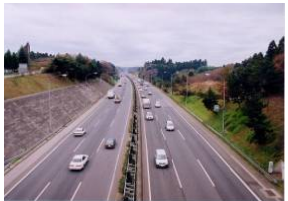
東関東自動車道 (仮)酒々井 IC 予定地付近
