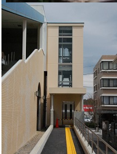
JR酒々井駅（東口） エレベーター設置
